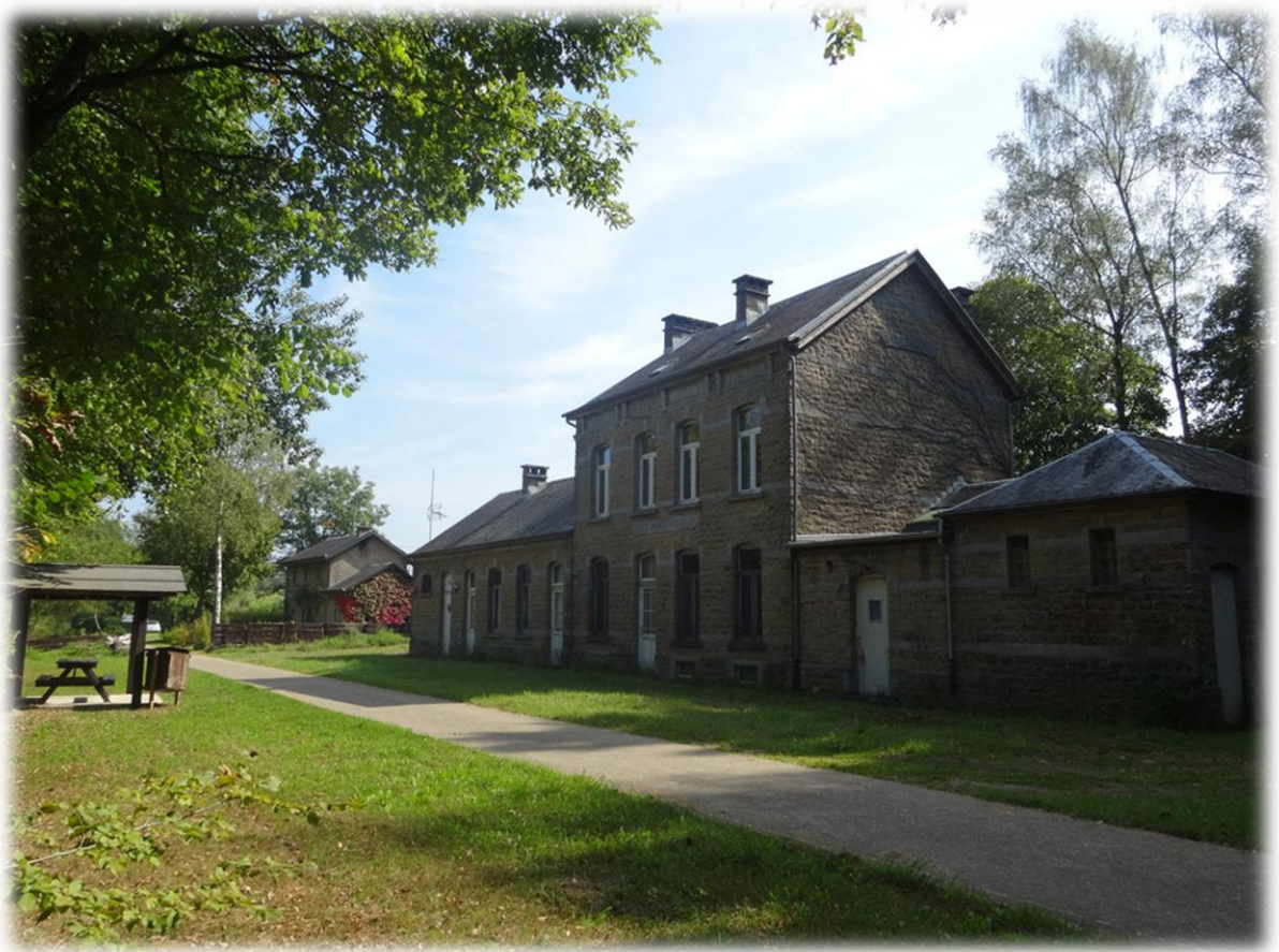
Het voormalige station van Buzenol lag aan de oude spoorlijn 155 die Marbehan via Virton met Ecouvies (F) verbond. Het werd in 1938 buiten dienst gesteld. De verwijdering van de
