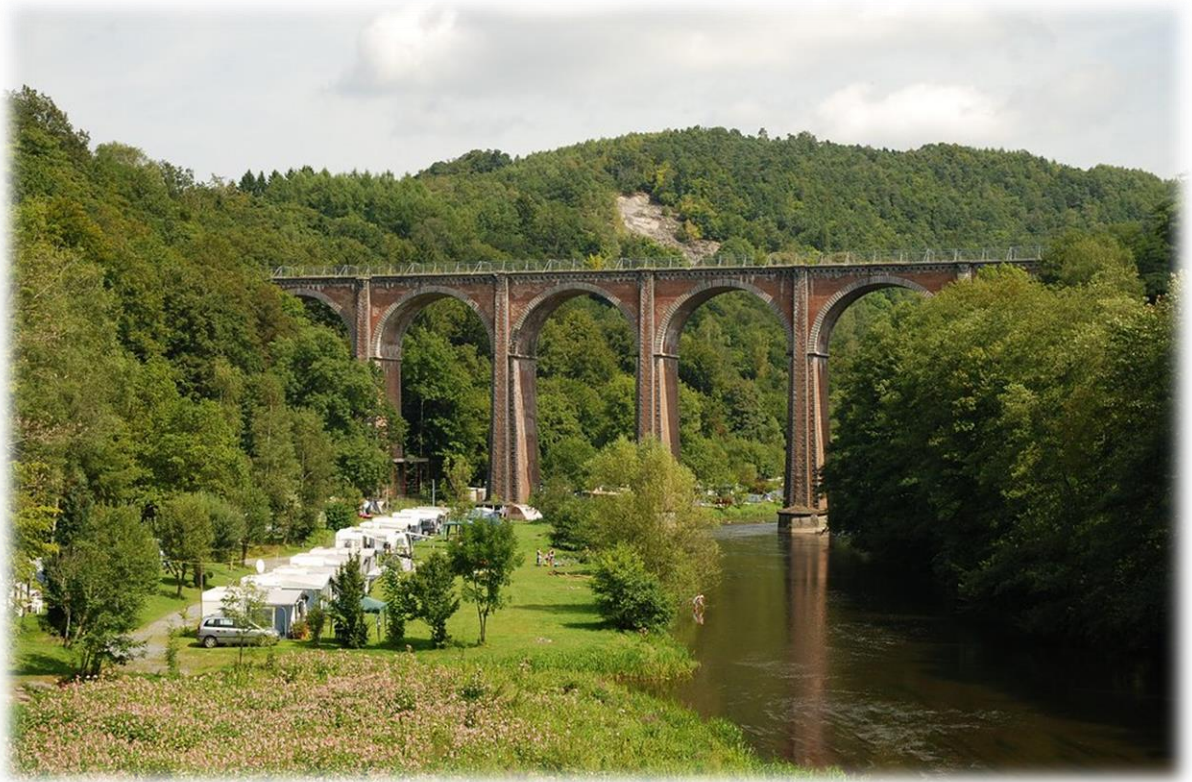
Het oude spoorwegviaduct van Herbeumont werd gebouwd in het begin van de 20 ste eeuw, voor de spoorlijn Bertrix-Herbeumont. Het viaduct bestaat uit meer dan 9 miljoen stenen,
