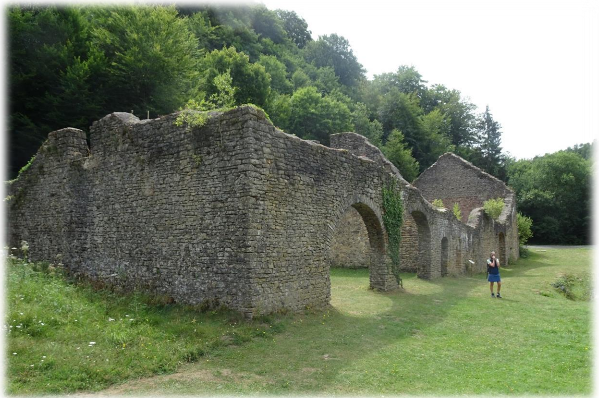
In Montauban draaiden de ijzersmelterijen gedurende 4 eeuwen op volle toeren. Momenteel staan er nog enkel de ruïnes van de voormalige hallen voor houtskool
